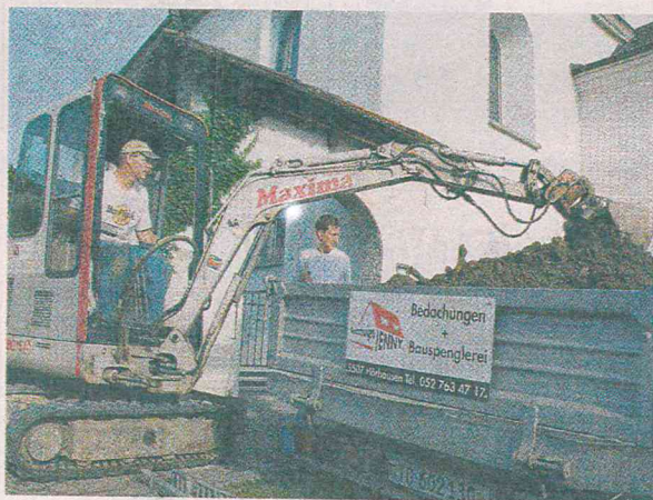
Mit einem kleinen Bagger heben Peter Jenny (rechts) und ein Mitarbeiter ein Grab aus.
